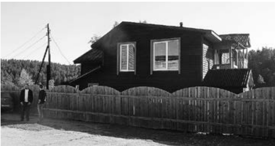
Kaksi Rainar Hakulisen pojanpoikaa Olli Hakulinen ja Jari Hakulinen vierailevat ukkinsa kotipihalla elokuussa 2013. Talo on korjattu samoin meijeri ja nyt siinä asuu uudet asukkaat.
