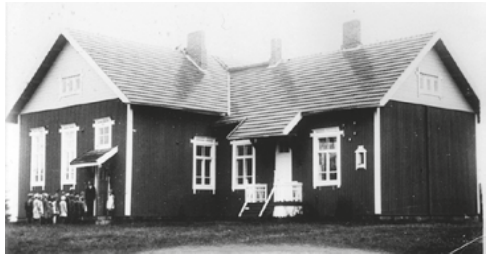
Ennen nuorisoseuratalon valmistumista Mikrilän kansakoulu toimi monien henkisten harastusten keskuksena. Vuonna 1930 ostettu nuorisoseuratalo (ent. työväenyhdistyksen talo) keskitti nuorisoseuratoiminnan omiin tiloihin.
