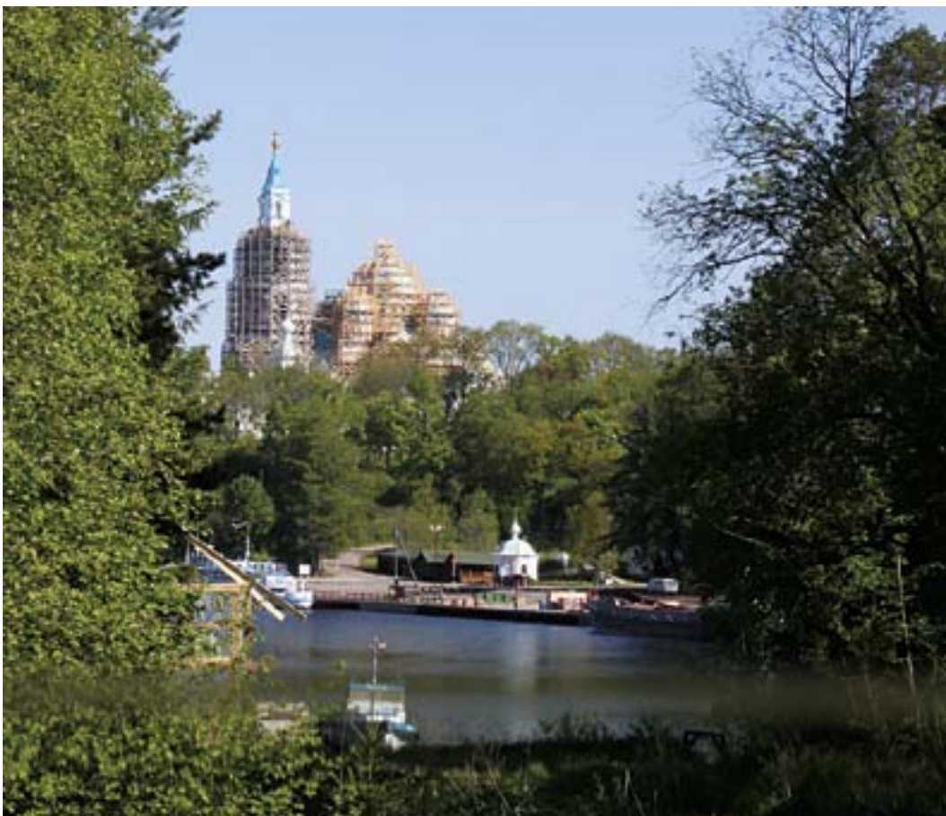
Valamon pääkirkon ulkopuoli ja tornit oli vuorattu lautaverhoilu ulkokuoren korjauksen vuoksi kesällä 2012.
