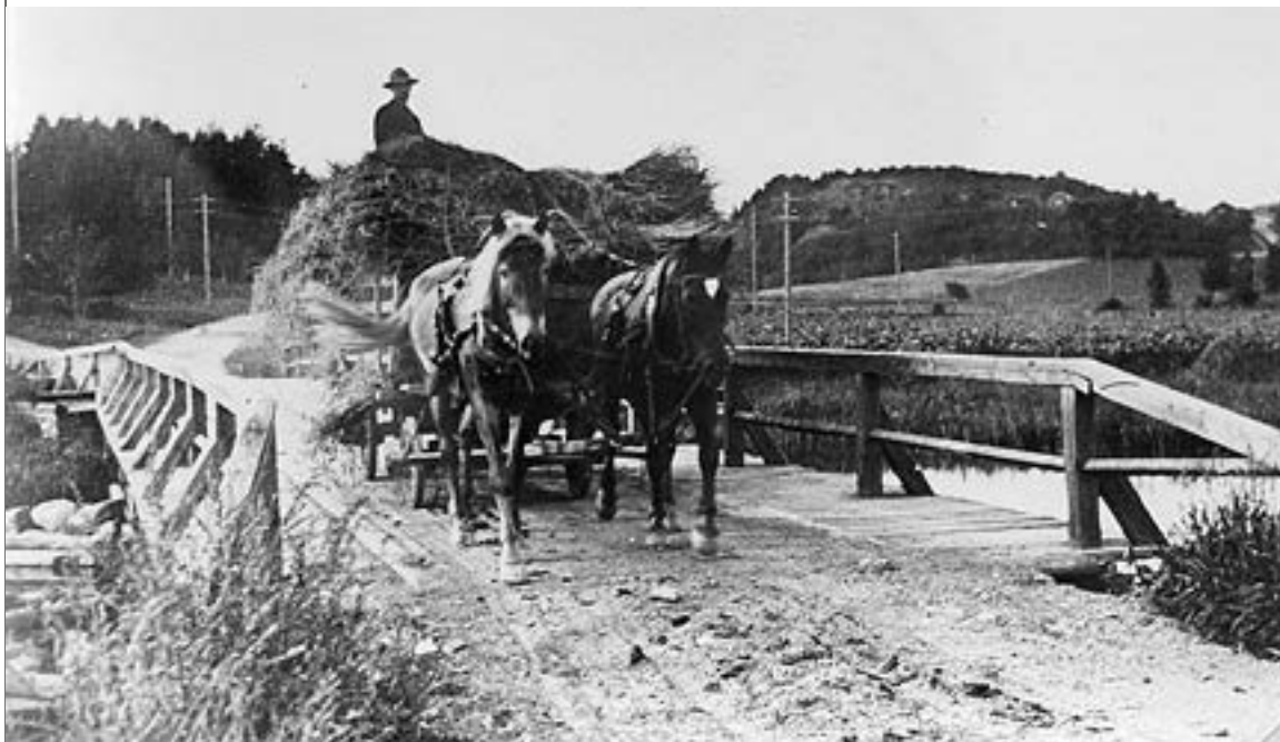
Elo on korjattu, mies ajaa kuormaa Lopotissa koulutilan saunasillalla.
