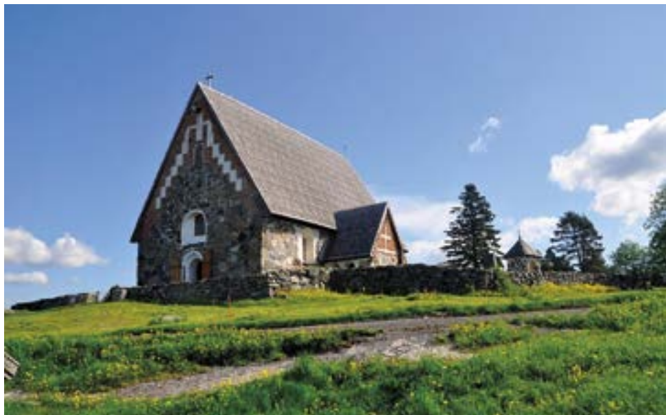
Tyrvään Pyhän Olavin kirkko on kokenut kovia, mutta nyt se seisoo ylväänä paikallaan. Kuva: Jari Mynttinen.
