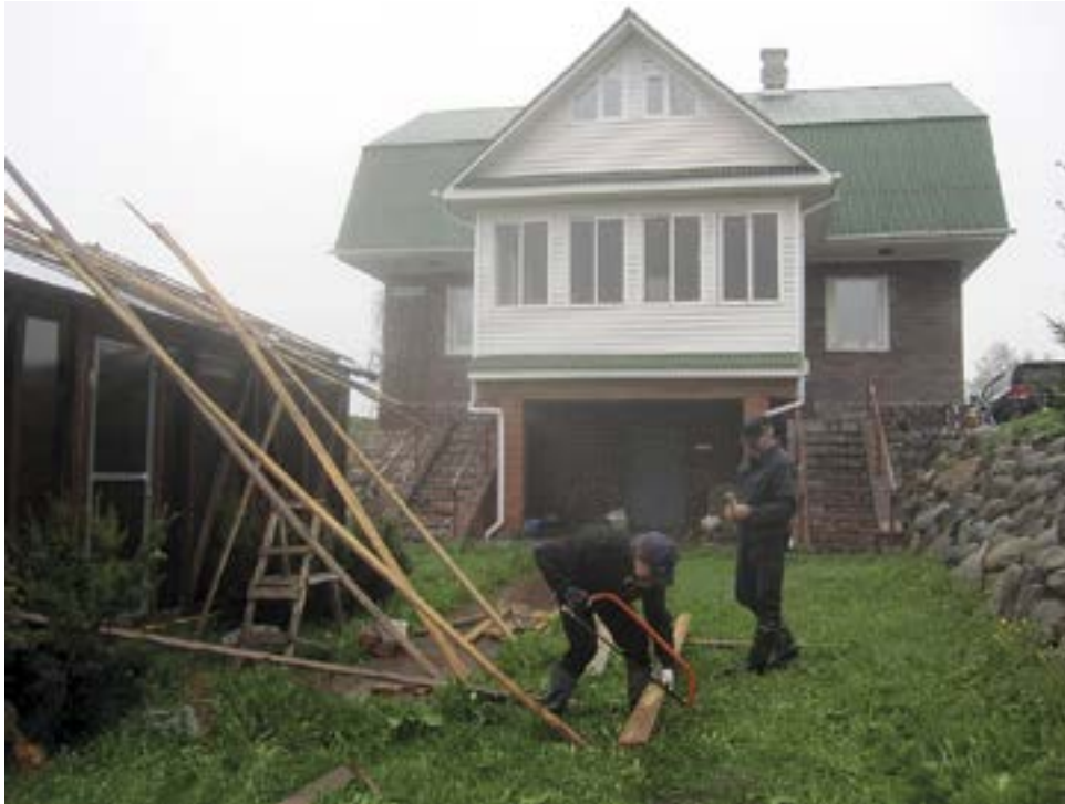
Talkooaamu valkeni sateisen sumuisena. Mihail lupasi katonkorjaukseen tarvittavat laudat uima-altaan kattorakenteensa ylijäämistä. Timo Rouhiainen (vas) ja Pekka Riikonen saivat tarvittavat pätkät mukaan. Kuva: Raimo Nenonen.
