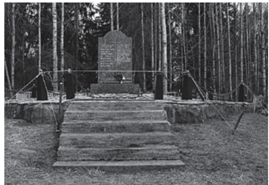
Kirkon muistomerkki (kellotapulien perustuksilla) kunnostustyön ja siistimisen jälkeen. Koristeketjujen kannatintolppien tukiköydet ovat vielä paikallaan, kunnes laasti on kuivunut.
