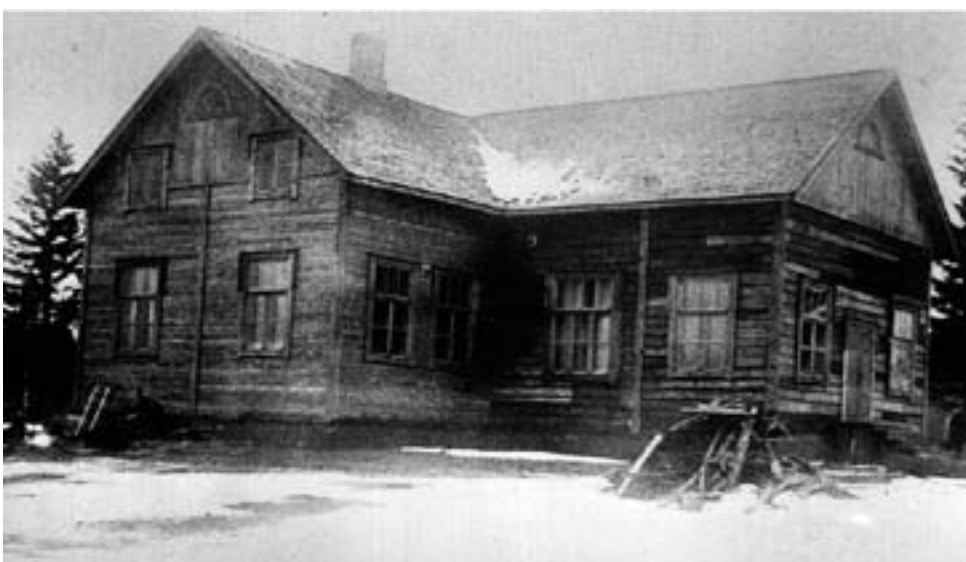
Sorjon huutömen Ns-talo valmistumisvaiheessa. Kuvaaja Eero Seppänen. Kurkijokimuseon kuvakokoelmat, kuvanro 3293.
