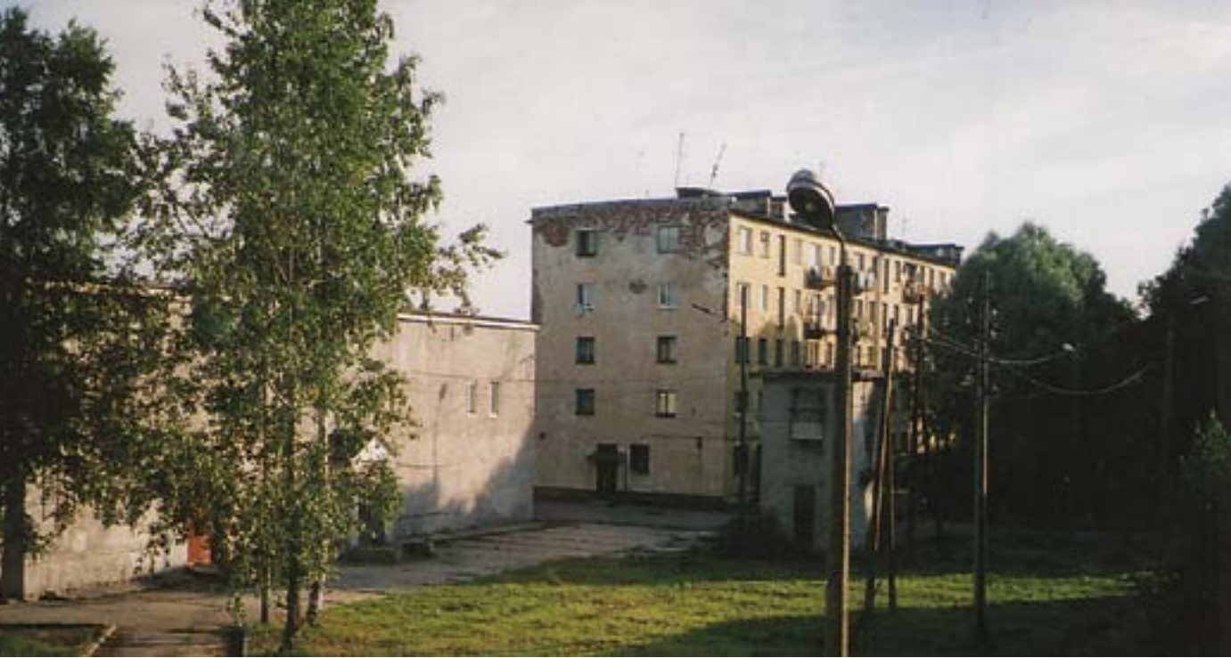
Aunuksen hotellin ikkunasta avautuva näkymä ei silmää hivellä. Neuvostoaikana rakennettu asuinkerrostalo rapistuu silmissä.
