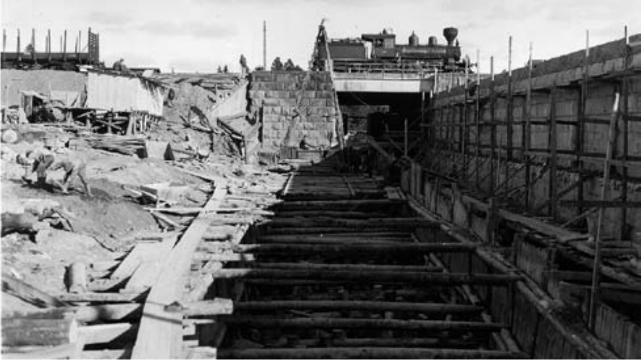
Siltatöitä Elisenvaarassa. Ratapihaa levennettiin 1930-luvulla, jolloin Pusutunnelikin piteni. Kuva: Riitta Sainion kokoelma
