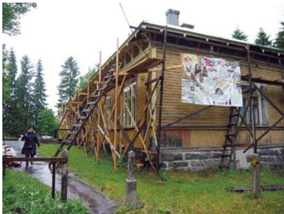
Kurkijoen maamiesopiston opettajien entinen asuintalo, jossa nykyään on Kurkijoen museo. Rakennusta on viime vuosina perusteellisesti kunnostettu.
