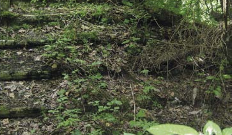
Päädyn kivijalan oviaukosta pääsee rapuille, jotka ovat peittymässä kasvuston alle. Kuva ML
