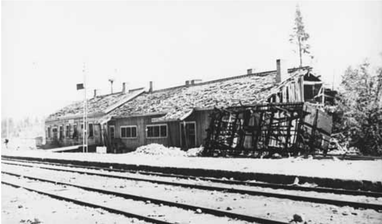
Elisenvaaraan jatkosodan aikana rakennettu asemarakennus 20.6 tapahtuneen pommituksen jälkeen. Aseman edessä on tuhoutunut rautatievaunu. Katolle on lentänyt tuhoutuneessa vaunussa kuljetettuja sanomalehtiä. Matti Rapon kokoelmat.
