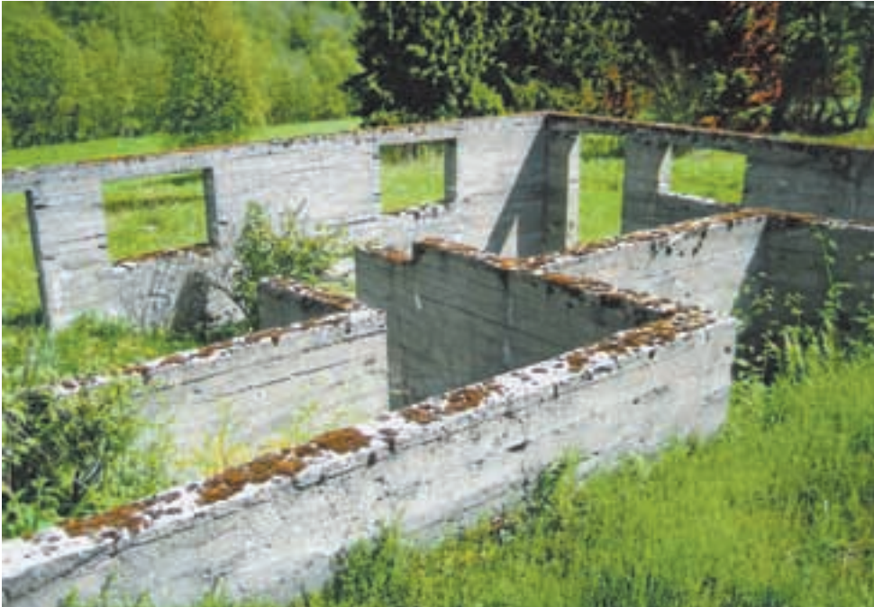
Asuinrakennuksen perustusta, jota tehtiin 1943-44. Pekka Kiiski oli räjäyttännyt kallioon kellarikerroksenkin. Nyt sammal koristaa betonia.
