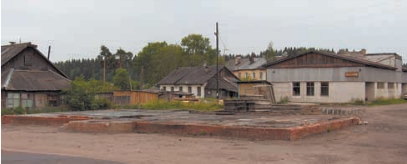
Hiitolan asemakylässä ollut tiilinen kauppakennus hävisi kesäkuun loppupuolella savuna ilmaan. Palojäte on siivottu pois. Ehkäpä paikalle nousee uusi entistä ehompi puoti. Kuva Raija Laaksonen.
