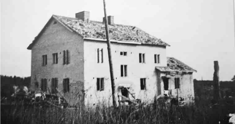
Elisenvaaran vuonna 1944 valmistunut posti- ja poliisitalo suurpommituksen jäljiltä. Poliisikostaapeli Nikkari perheineen ehti asua muutaman kuukauden talon toisen kerroksen päädyssä. Päädyn ikkunat ovat asemalle päin. Katon läpi tuli pommi, joka pysähtyi postin hoitajan asuntoon ja jäi suutariksi. Sotavangit purkivat sen. Talo toimi myöhemmin rautatieläisten klubina. Nyt monet ikkunat on peitetty laudoilla. Kurkijoki-museon kokoelmat.
