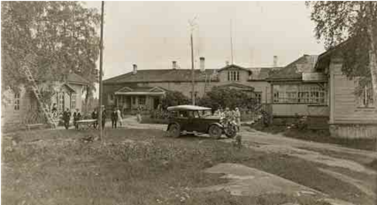
Tervun hovin pihanäkymä 30-luvun alusta kuvassa. Hovi siirtyi Kurkijoen kunnan omistukseen vuonna 1919, ja siitä tehtiin kunnalliskoti. Taustalla kunnalliskodin päärakennus, vasemmalla sairaala, oikealla tilanhoitajan asuin- ja konttorirakennus. Kuva on luultavasti Toivo Immosen ottama. Etualalla olevan auton omistajasta ei ole varmaa tietoa. Toivo Immonen hankki opiskeluaikanaan vuonna 1929 käytetyn kanttihopan (Fordin) ajaakseen sillä kesälomalle Helsingistä Tervuun. Sakari Karsila on kirjoittanut runsaasti kuvitetun esityksen Tervun hovista Kurkijoen nettisivuille www.kurkijoki.fi
