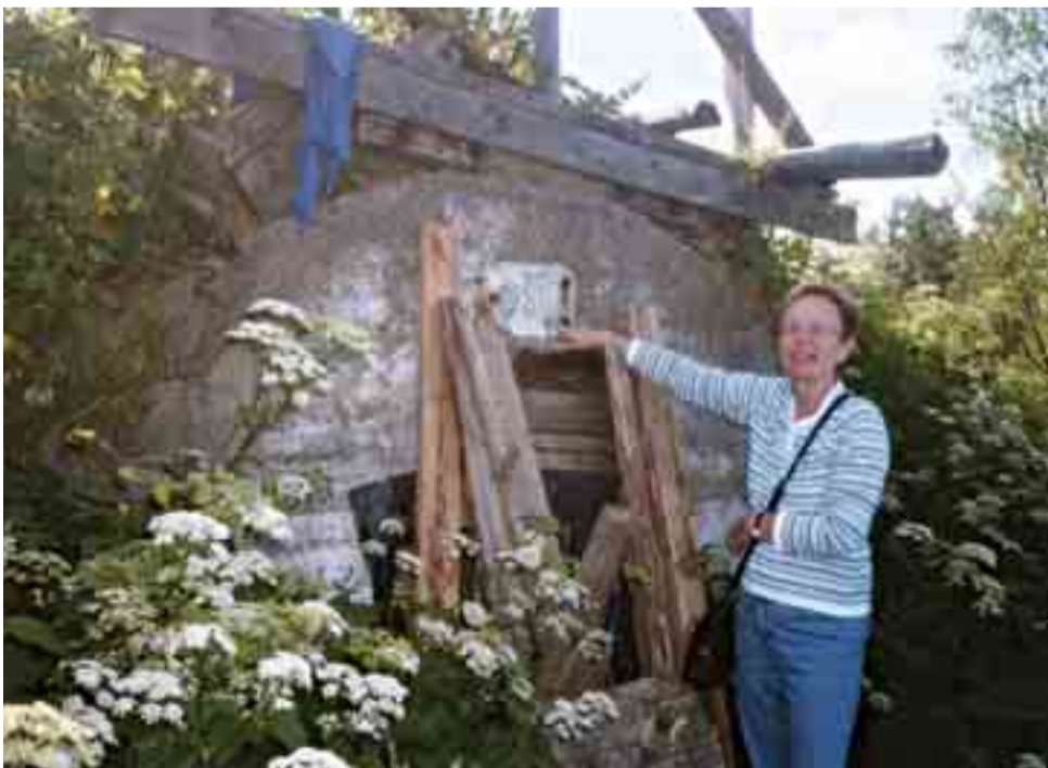
Pekka Löyhkön ja Antti Partasen (Joonas Kokkosen eno) vuonna 1931 rakentama maakellari. Tuula osoittaa betoniin piirrettyä vuosilukua.
