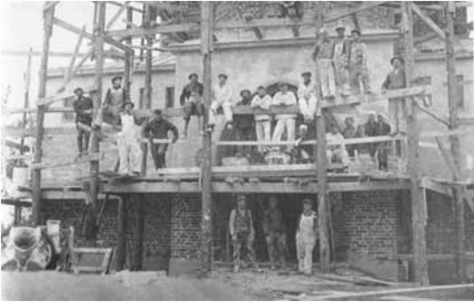
Lumivaaran kirkon rakennusvaihe 1934. Kirjasta Lumivaara kuvina.
