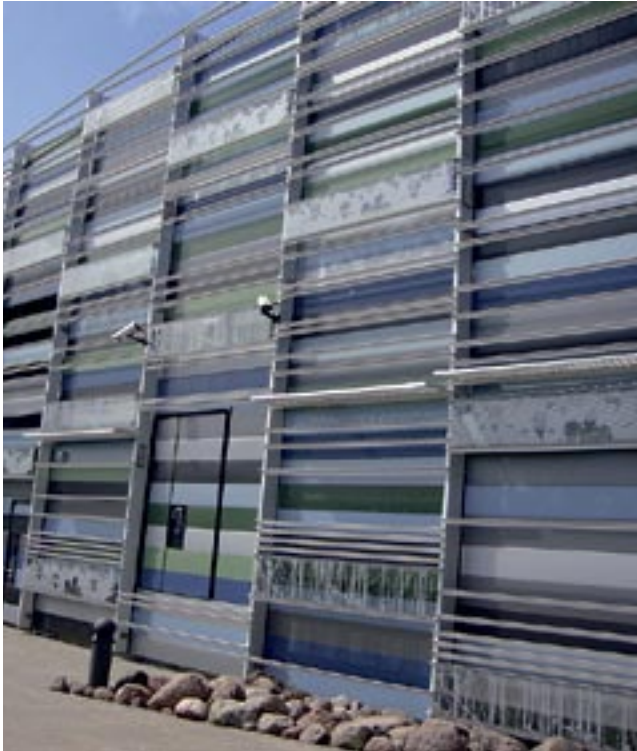
Merikeskus Vellamon seinärakenne on lähempää tarkasteltuna erikoinen.
