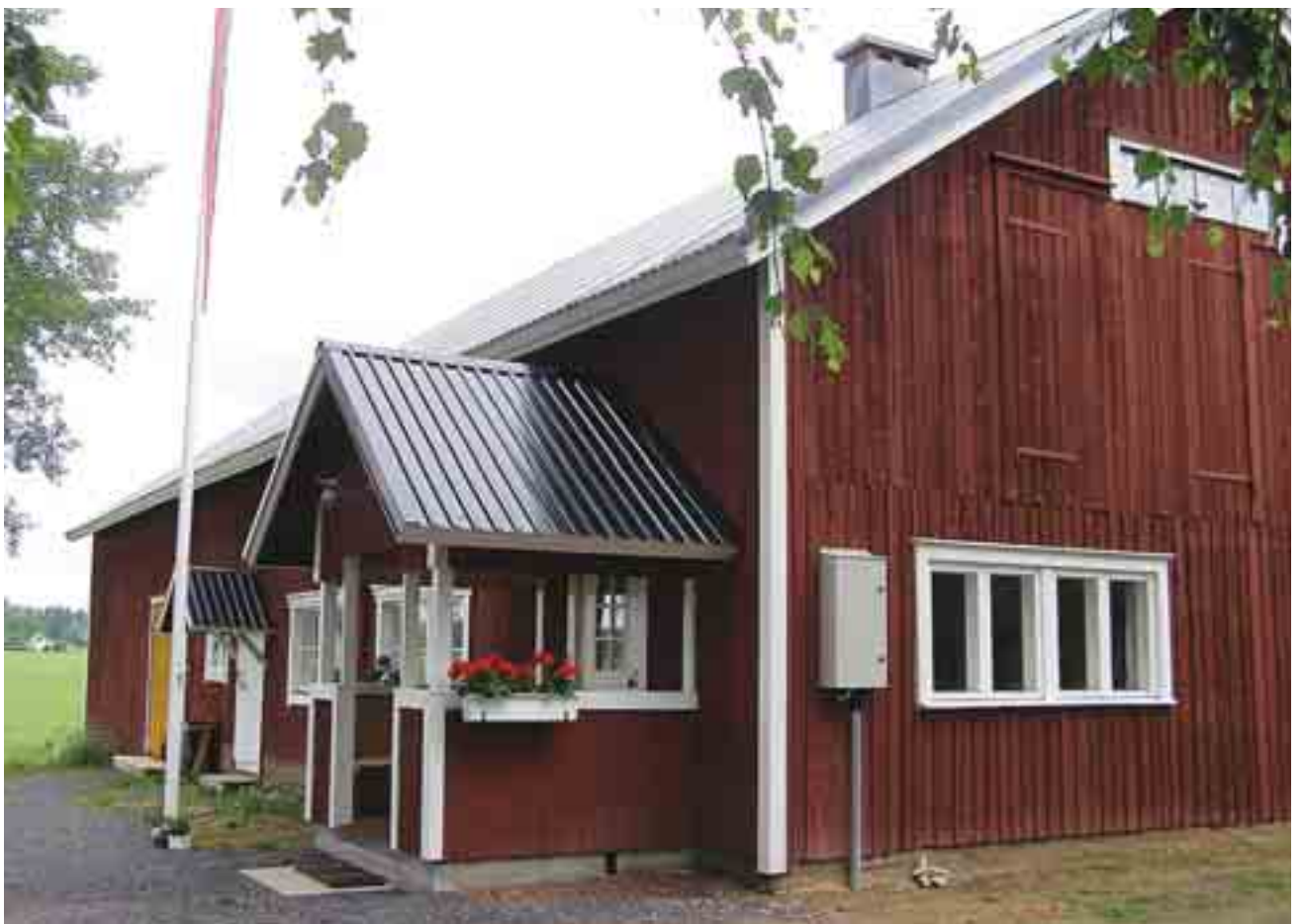
Tyypillinen Vampulaan noussut karjalainen pika-asutustilan rakennus, missä asunto oli joko päädissä tai keskellä. Päädissä ylhäällä oleville kaksoisoville johti hevosella ajettava silta.
