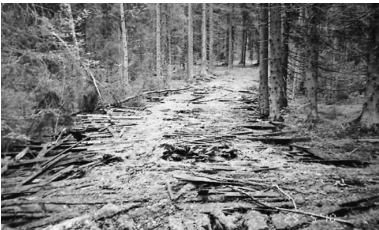
Tienrakennuksen kummallisuus Marianvaaran metsässä. Merran pihapiiristä oli metsään tehty tie pintalaudoista. Kerroksen paksuus oli 30-50 cm. Tien rakennuspaikka oli kivennäismaata. Tietä oli käytetty vähän ja se oli jo lahoamassa kulukelvottomaksi.
