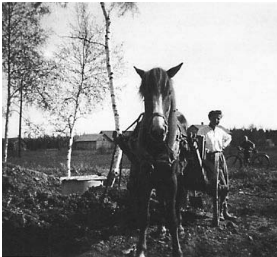
Hevonen oli apuna moninaisissa töissä uutta rakennettaessa.
