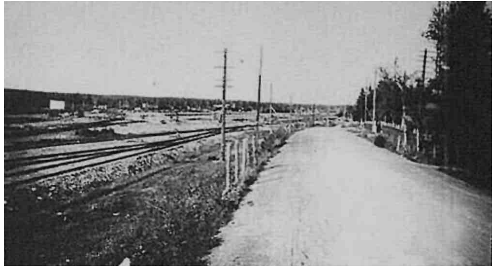
Näkymä Elisenvaaran asemaseudulta syksyllä 1941 kohti Tervaporttia ja Elisenvaaran asemaa. Vasemmalla Viipuri-rata on tällä kohtaa ehjä. Kaatunut valonheittäjätorni näkyy kuvan vasemmassa reunassa.
