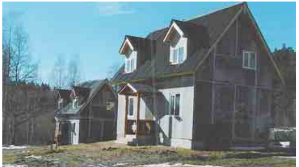
Kolme uutta mökkiä on noussut Hännisenlahdelle Vätikän ja Tervun välimaastoon. Ravintolarakennus on rakenteilla ja pihatyöt vielä tekemättä tällä luonnonkauniilla Laatokan rannalla. Majoitusaluetta rakentaa sama Mihail, joka omistaa kirkonkylällä ns. Sonckin talon vieressä sijaitsevan "Mikon talon".
