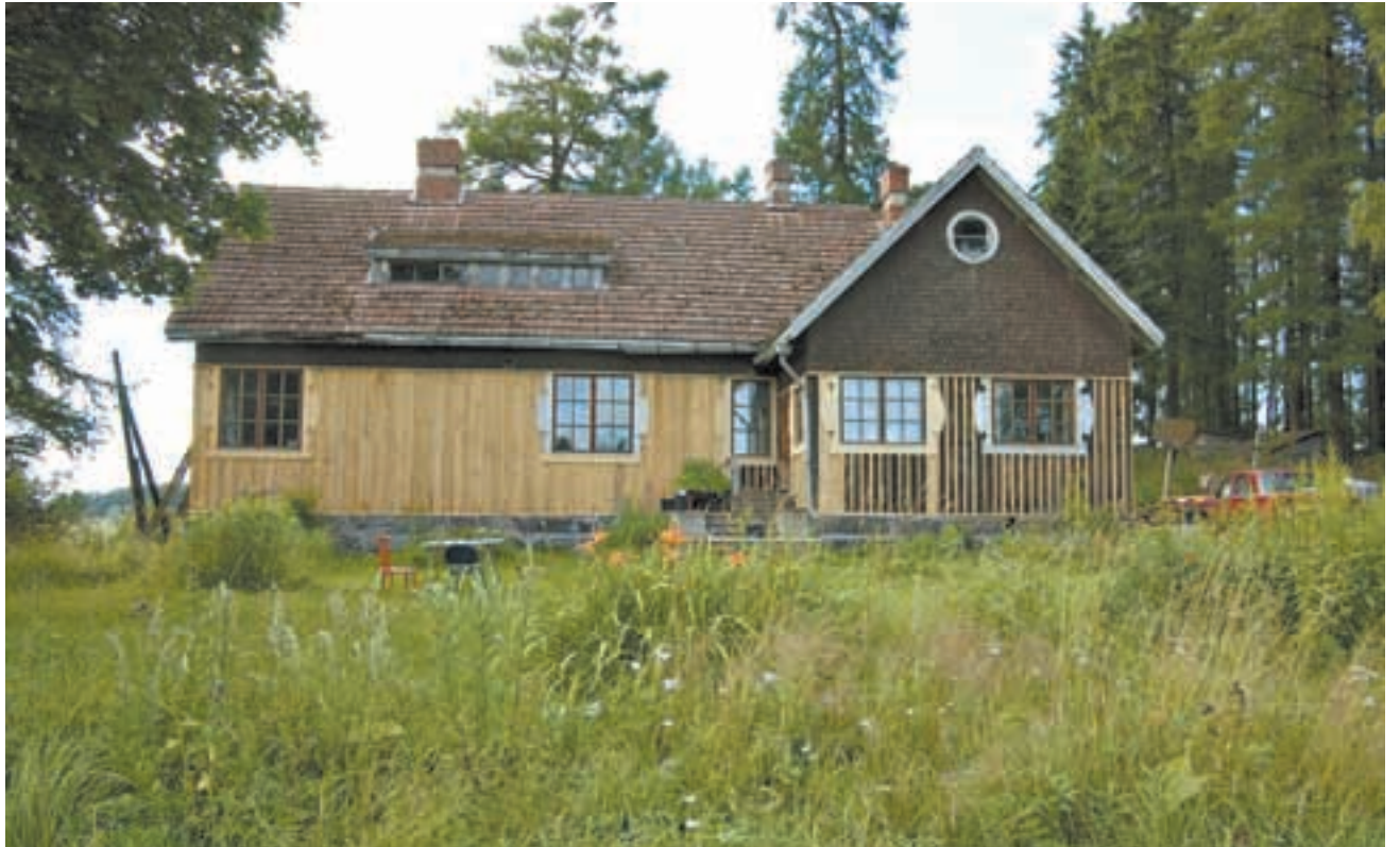
Elokuussa 2005 Sonckin talon vuorilaudoittaminen oli pitkällä. Kirvesmies noudatti alkuperäisen laudoituksen mallia ikkunoiden kehyslautoja myöten. Kuva Juhani Seppovaara.
