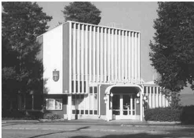
Pöytyän kunnantalo toimii edelleen kunnan virastotalona Pöytyän ja Yläneen yhdistyttyä.
