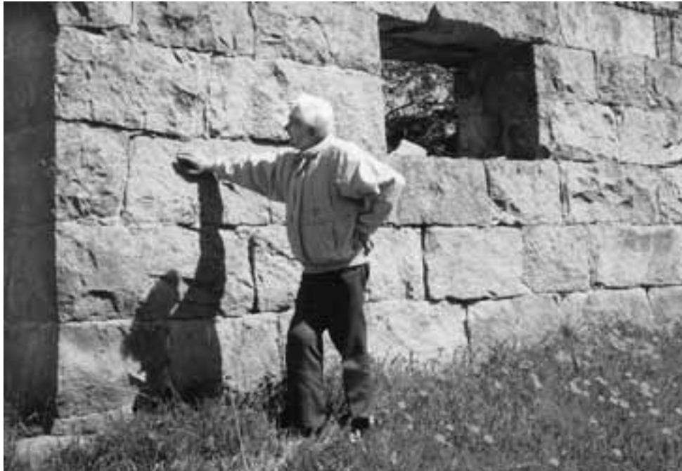
Poutasen yli 100-vuotisen kivilavetan pystyssä olevia seinii.
