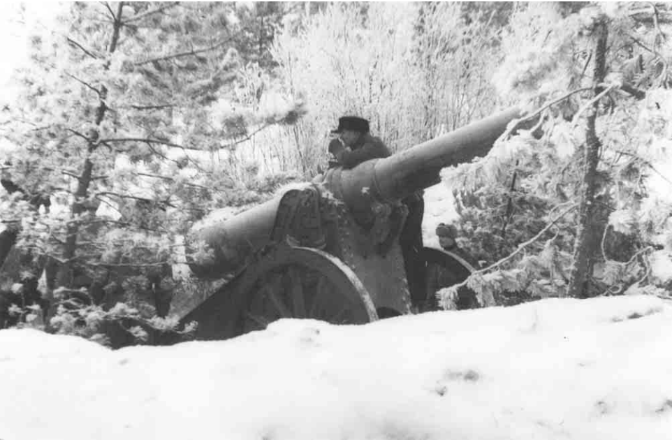
Raikkaun patterin tykki ”Olavia” suunnataan. Tykkimalli 152 K 77 (eli 6-tuumainen jäykälavettinen kenttäkanouna vuodelta 1877). Tämä tykki oli ainoa patterilla sen jälkeen kun 6.12.1939 toinen vietiin rintamalle Impilahdelle, ”Olavi” siirrettiin asemastaan Lapinlahdelta myös rintamalle helmikuussa 1940. kuva: Jorma Haapkylä, Rainar Hakulisen kokoelma
